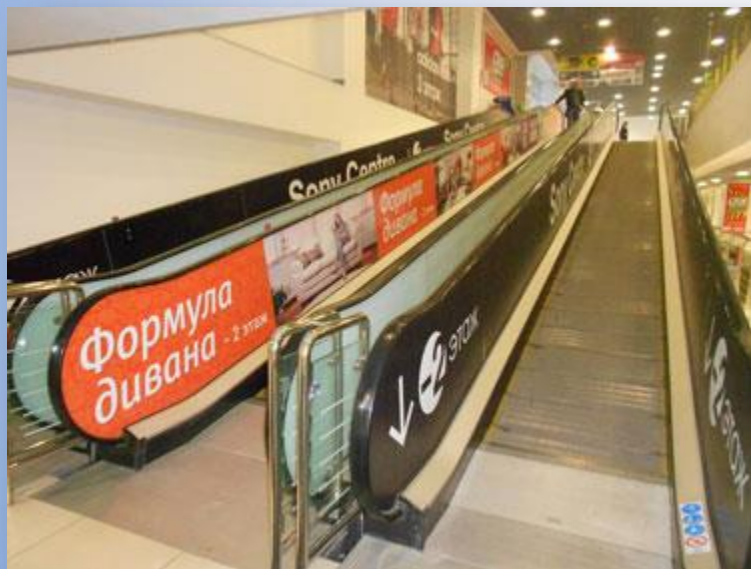
Траволаторы с 1 на -1 этаж
